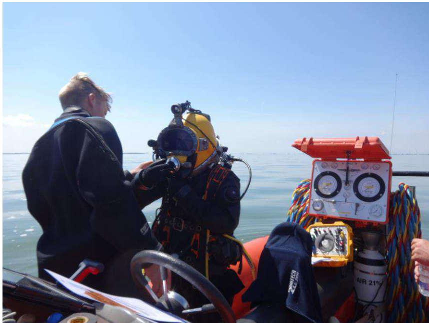
Afbeelding 4. Voorbereiding voor het duikwerk.
