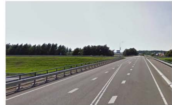
geïntegreerde geleiderail en hekwerk viaducten A6
