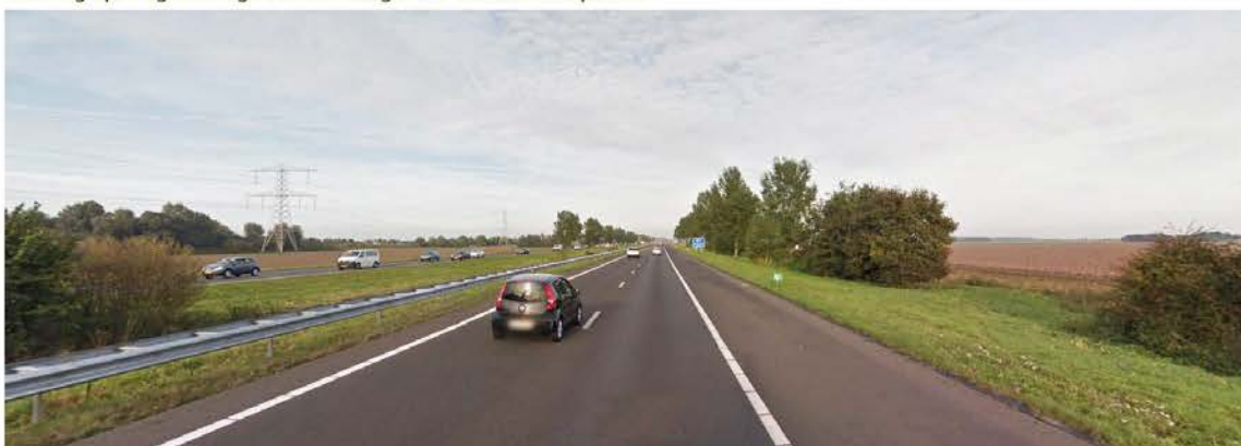
A6 t.p.v. nieuwe aansluiting
