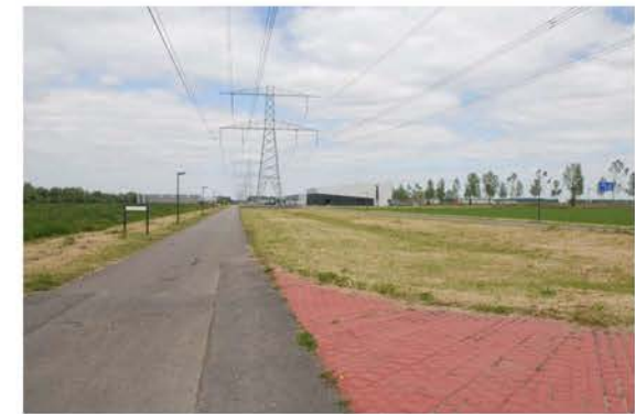
380 kV leiding tussen Larservaart en A6
