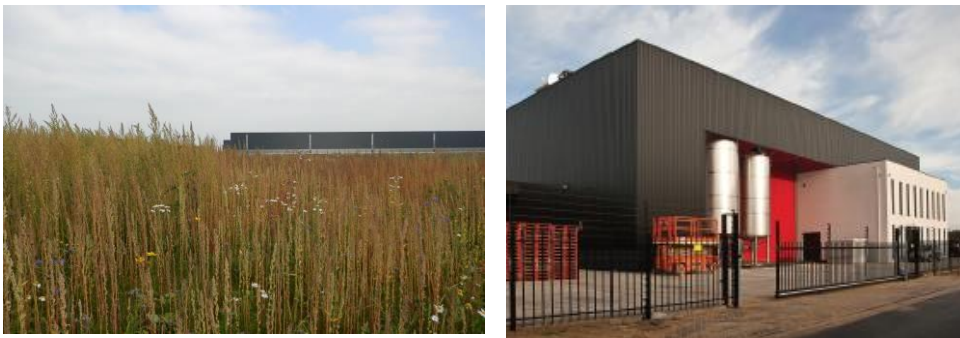
Figuur 9. Impressie van enkele gebouwen in het plangebied.
