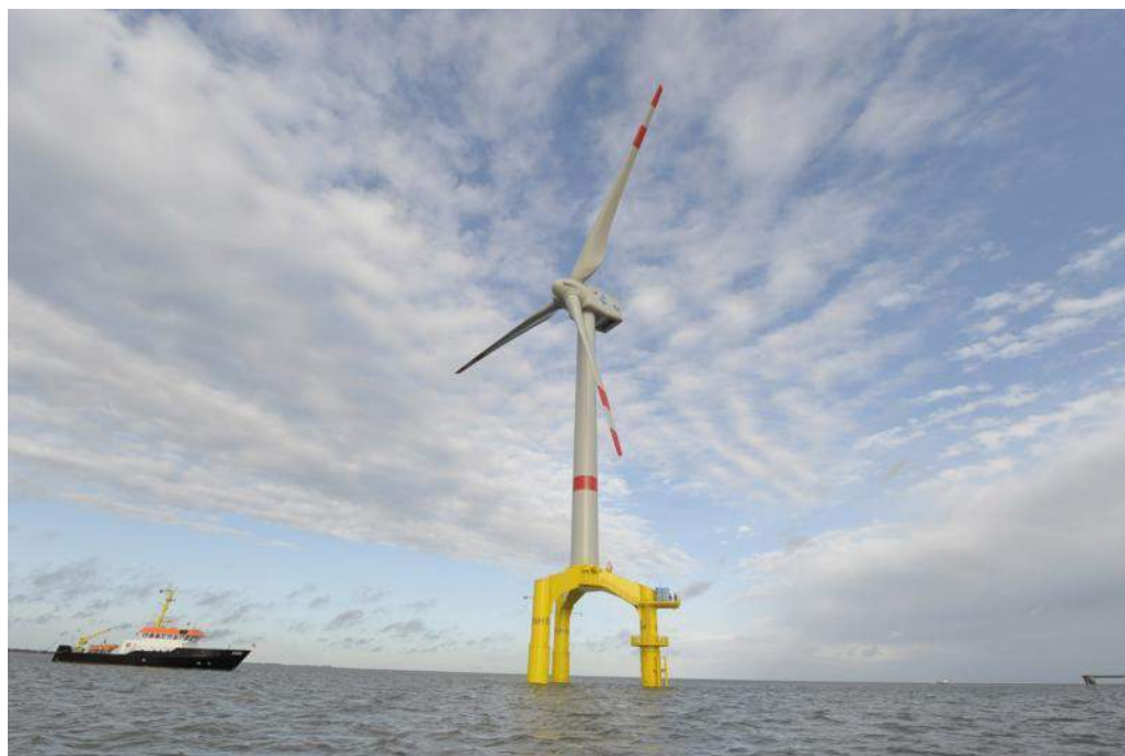
Figuur 3.5 Voorbeeld van een tripile fundatie 2
