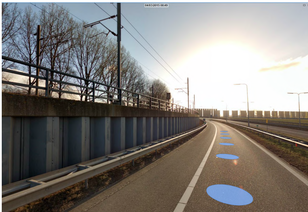
Figuur 12: Situatie aansluiting bestaande spoor noordoostelijke zijde trace, Europaweg, kijkrichting oost (bron: Globespotter 3.1, Cyclomedia, opnamedatum 4-3-2015)
