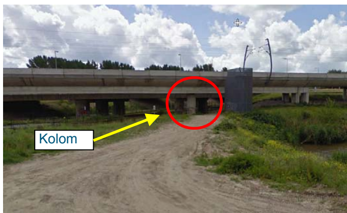
Figuur 1.10: meetlocatie gezien van af Blindeweg
