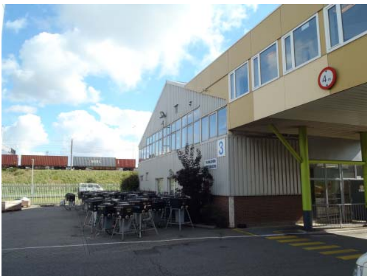
Figuur 4.3: onderzijde brugkantoor EQIN; stalen kolommen rond 200mm
