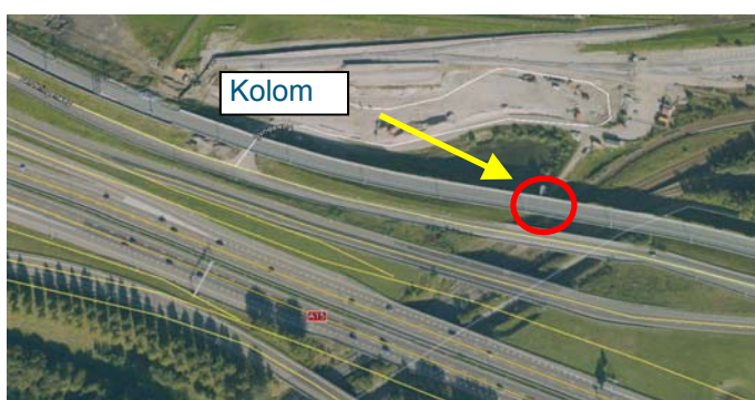
Figuur 1.9: situatie Blindeweg te Rotterdam met locatie kolom 18 rode cirkel
