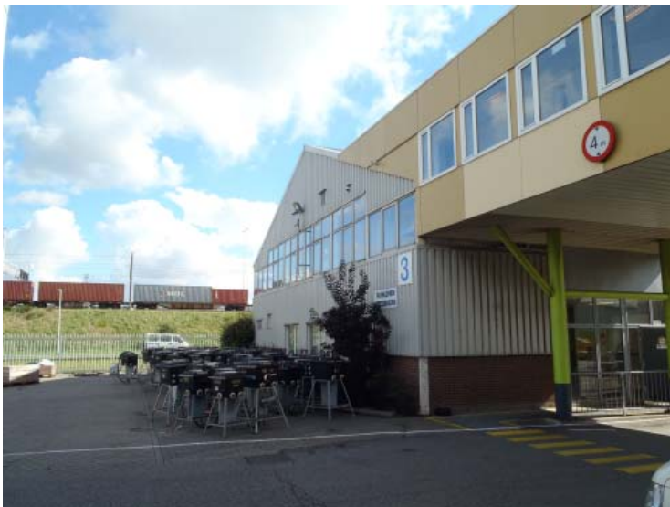
Figuur 5.4: onderzijde brugkantoor Egin; stalen kolommen rond 200mm
