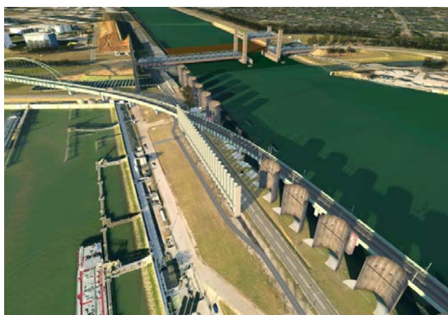
Figuur 53 Oostelijke passage Theemswegtracé kruising windscherm (vanaf Calandbrug gezien)
