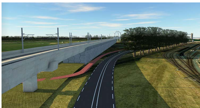
Figuur 44 Theemswegtracé met verhoogde gewapende grondconstructie
