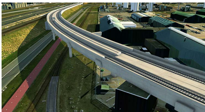
Figuur 42 Theemswegtracé aansluiting havenspoor oost d.m.v. trogliggers
