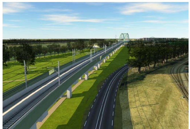
Figuur 64 Impressie pijlerconstructie kunstwerk met prefab dek
