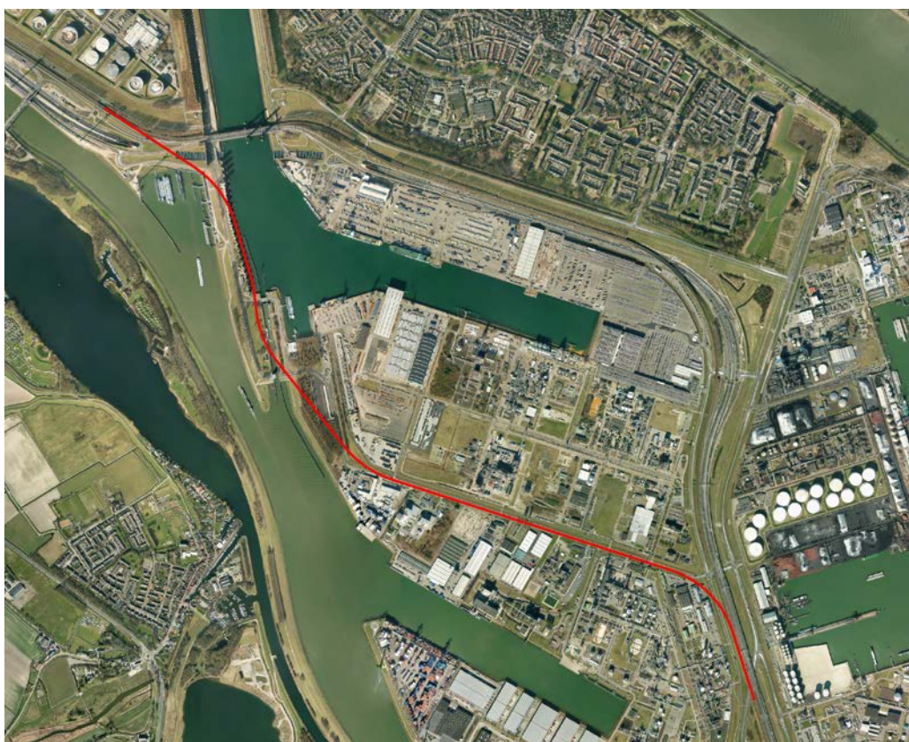
Figuur 11 Theemswegtracé met oostelijke passage windschermen
