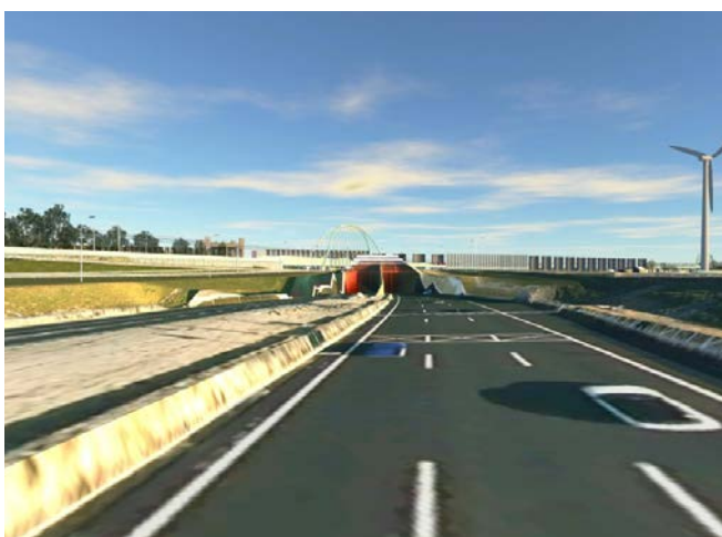
Figuur 52 Zicht op Theemswegtracé, windscherm en Calandbrug vanuit A15
