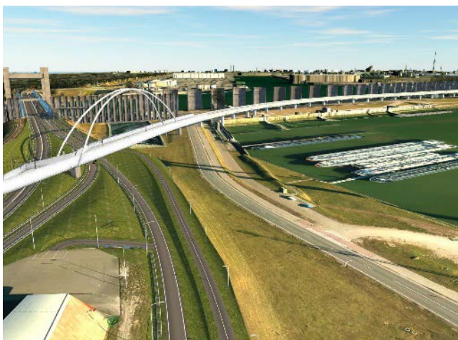
Figuur 50 Theemswegtracé met boogbrug over Thomassentunnel-westelijke passage
