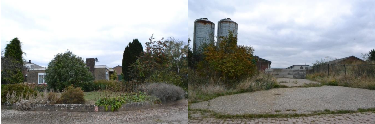
Figuur 3.5 Gebouwen van het stallencomplex Zwaarveld 1 -3 met onder de boeiboorden zomer- en paarverblijf gewone dwergvleermuis.
