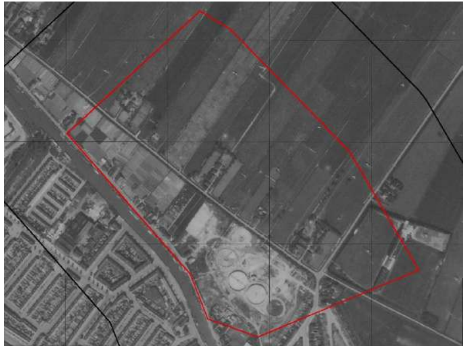
Figuur 2.1: Start bouw rioolwaterzuivering Utrecht in 1955/1956 [35]
