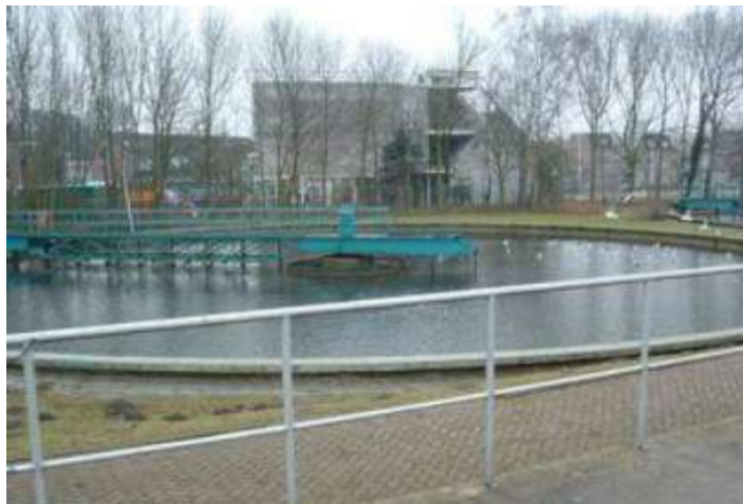
Figuur 5.16: Eén van de bezinktanks RWZI Utrecht
