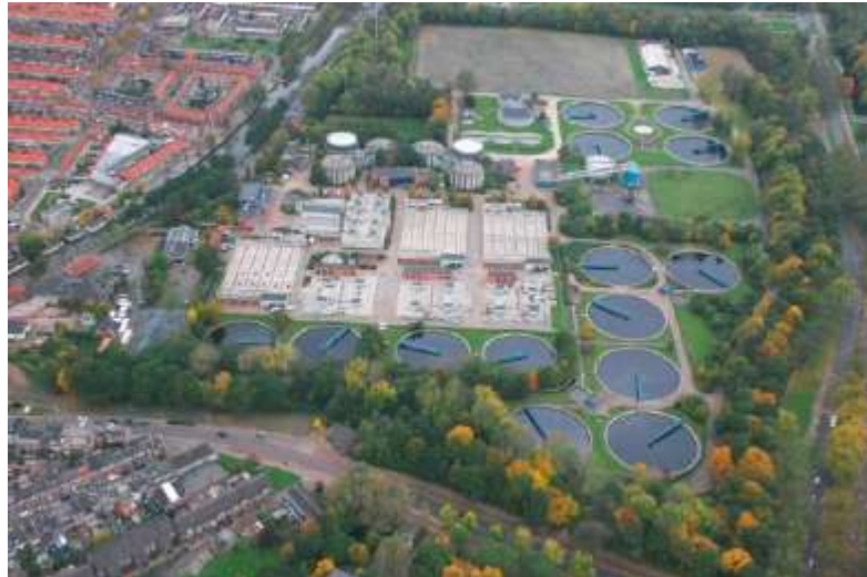
Figuur 5.14: Luchtfoto RWZI vanaf zuidzijde
