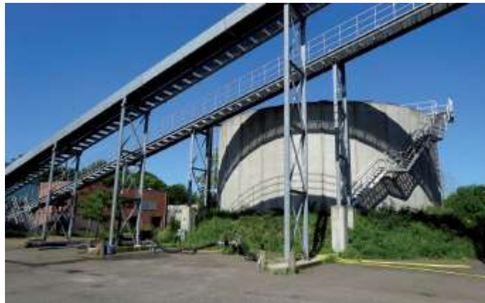
Figuur 7.1: Beeld slibverwerkingsinstallatie.
