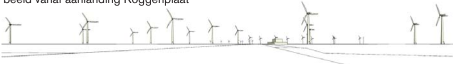
beeld vanaf aanlanding Roggenplaat
