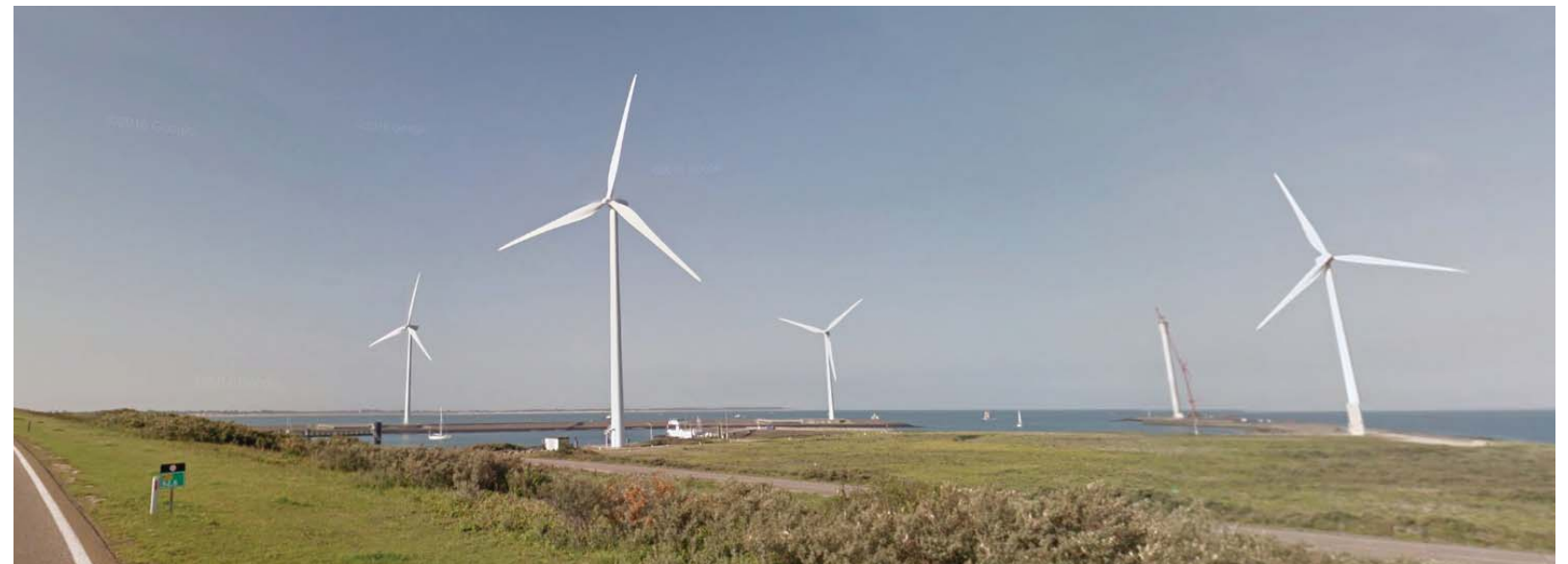
bestaande opstelling Noordland Buiten
