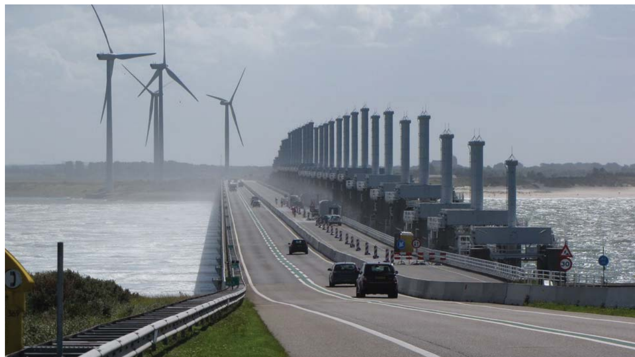
Oosterscheldekering gezien vanaf de noordzijde op Roggenplaat
