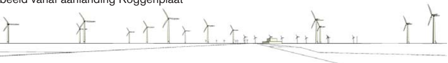
beeld vanaf aanlanding Roggenplaat
