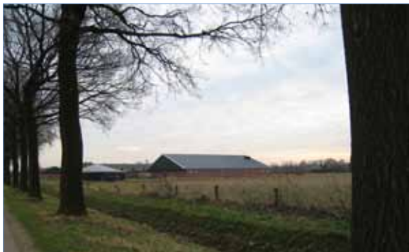
Grootschalig bedrijf in deelgebied I
