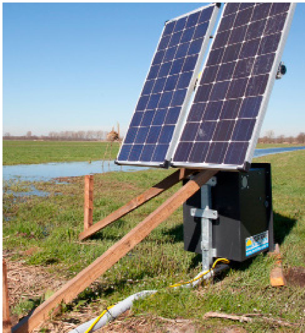
Water op het land door middel van een pomp op zonne-energie in de Lopikerwaard.
