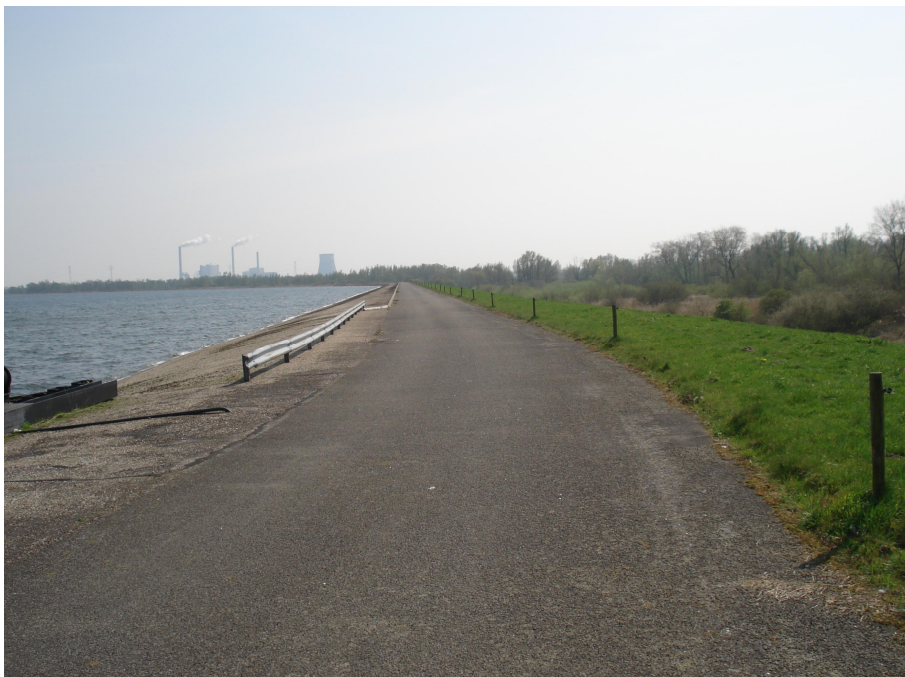
Foto 1 Ringdijk spaarbekken De Gijster
