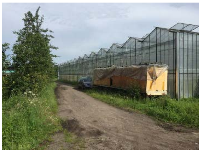
Figuur 3.9 De bestaande kassen, direct naast de Galgeveldseweg
