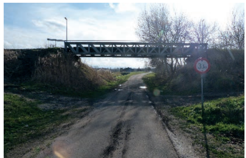
Huidige onderdoorgang Spoordijk
