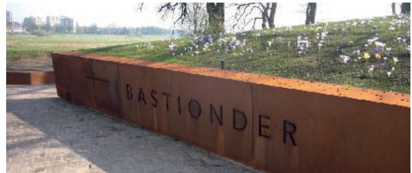
letters gesneden uit platen van weervast staal
