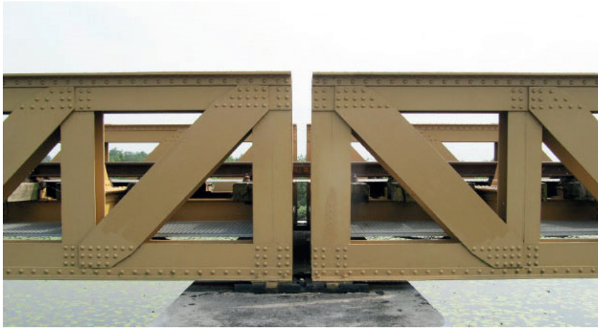
horizontaal zwevend karakter wordt door stelstukken tussen ligger en pijler bewerkstelligd
