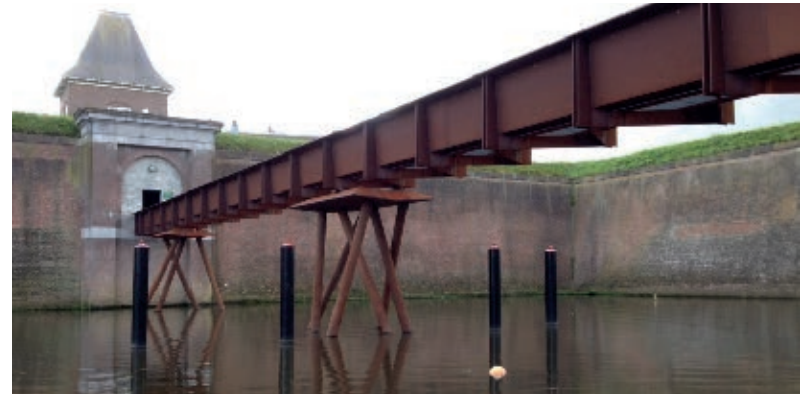
brug van weervast staal
