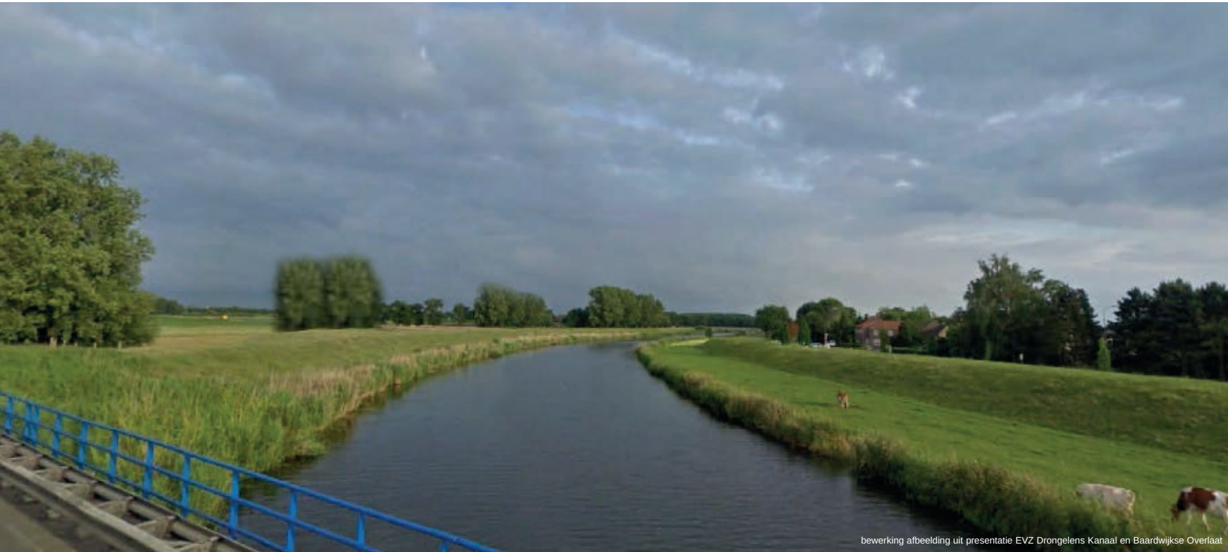
EVZ is liniar en ligt aan de teen van de dijk.
