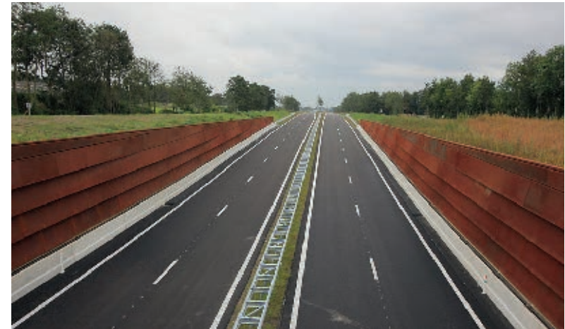
weervaste stalen wanden zorgen voor een hoogwaardige tunnelwand afwerking met een eenvoudige cleane snede.
