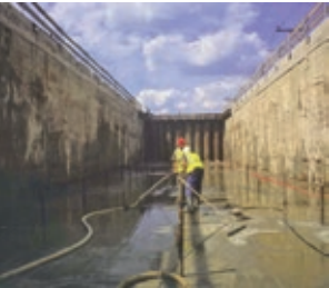
Stap 5 afwerken van de vloer en wanden verdiepte ligging
