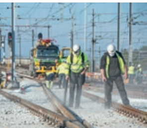
Stap 6 bouwen van rails, bovenleidingen, beveiligingsinstallaties etc.
