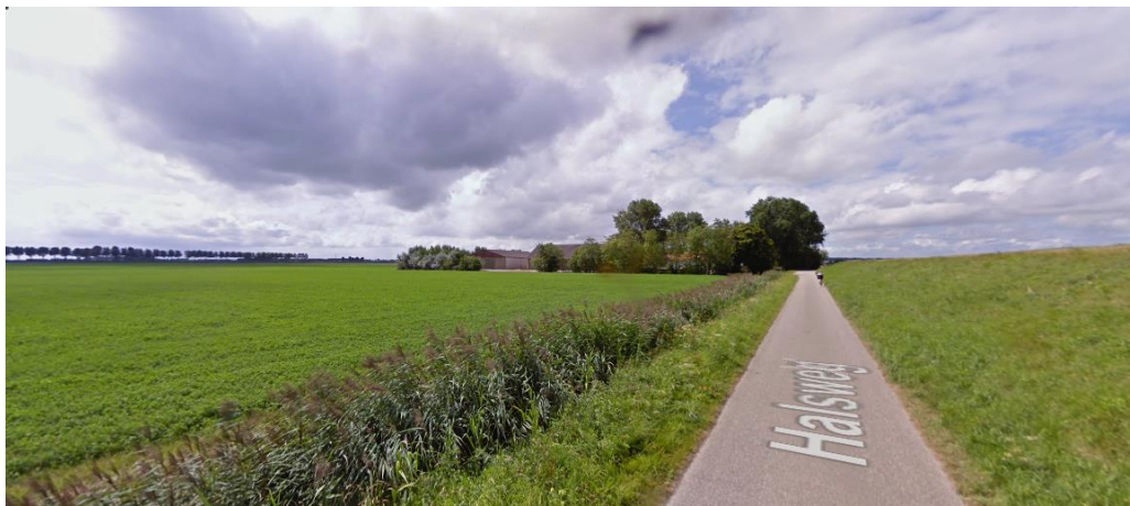
Figuur 3.4 Foto huidige situatie plangebied t.h.v. gepland transformatorstation
