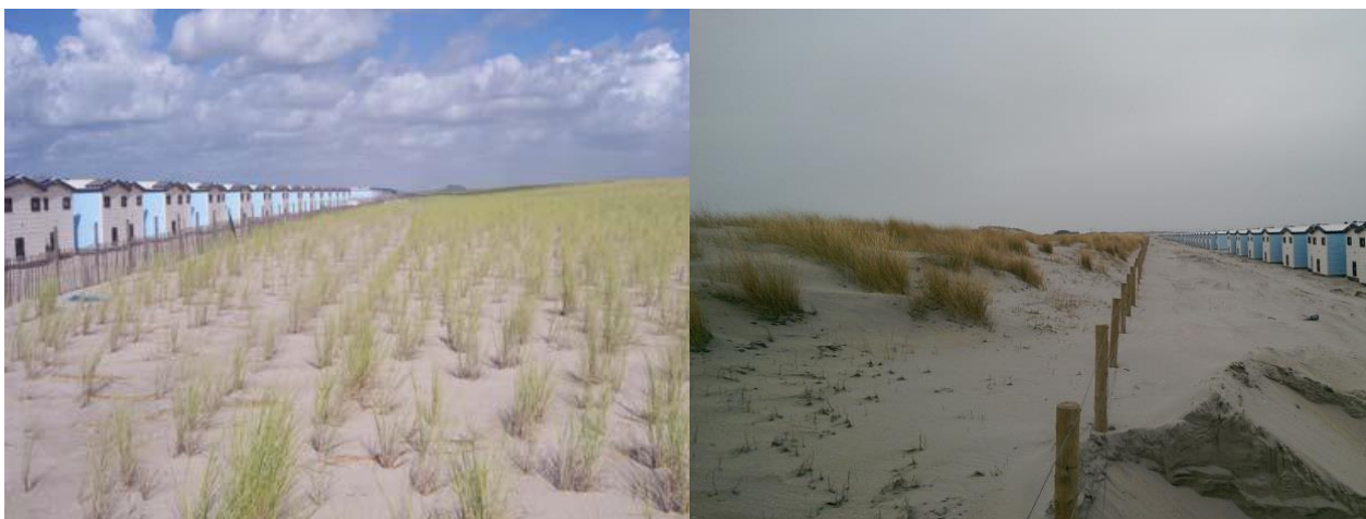
Figuur 9 Ontwikkeling van duinen bij het Spanjaardsduin. Foto links (genomen in noordelijke richting): hoogte van het basisduin direct achter de strandhuisjes direct na aanleg. Foto rechts (genomen in zuidelijke richting): hoogte van het basisduin direct achter de strandhuisjes tijdens veldbezoek in maart 2015 (Bron: Arcadis, 2015)
