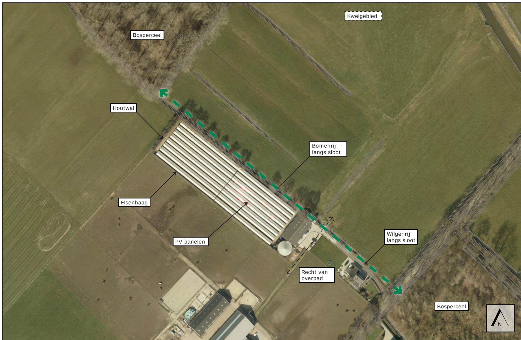
Figuur 3 - Luchtfoto bestaande situatie
