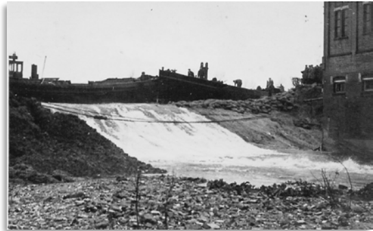
Figuur 3 Schepen dichten het gat in de dijk
