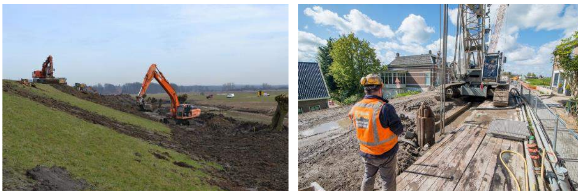
Figuur 54 Verschil in uitvoering grondoplossing en constructief
