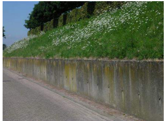
Figuur 51 Voorbeeld damwand in talud dijk
