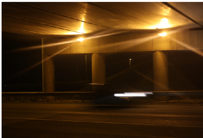
Geïntegreerde (LED)verlichting in viaduct. Onderdoorgangen ruim verlichten
