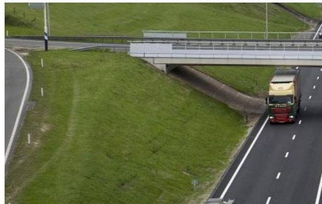
Referentiebeeld grastaluds ter hoogte viaduct
