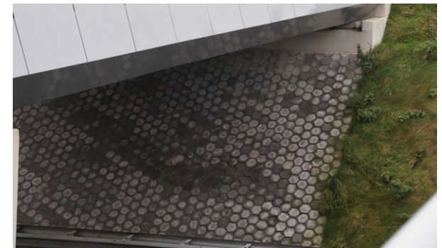
Referentiebeeld taluds onder viaduct
