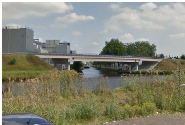
Huidige brug over de haveninvaart Oude Haven in Veghel.
