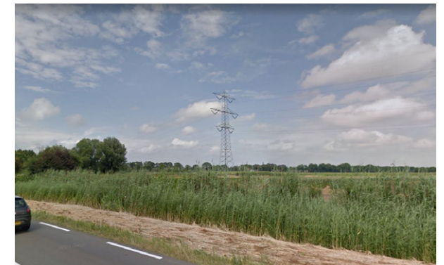
Hoogspanningsmast ter hoogte Wolfsputterbaan/Scheepstal
