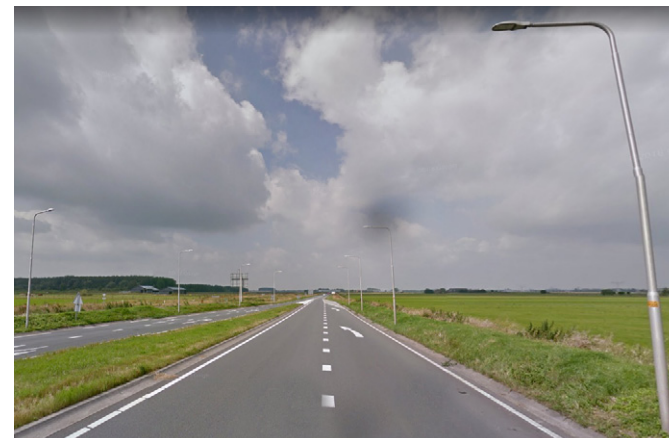
Eenduidige toepassing van sobere verlichtingsmasten in de buitenbermen ter hoogte van de in- en uitvoegers, van hetzelfde type als de verlichting van de N279-Noord.
