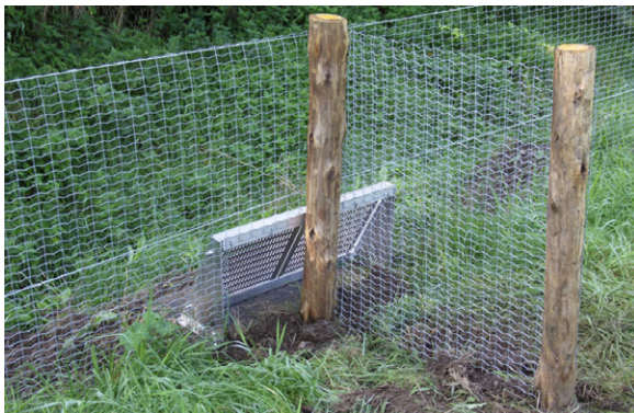
Voorbeeld van een dassenklep en raster
