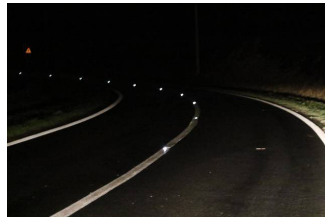
Subtiel aanlichten van het wegdek.
