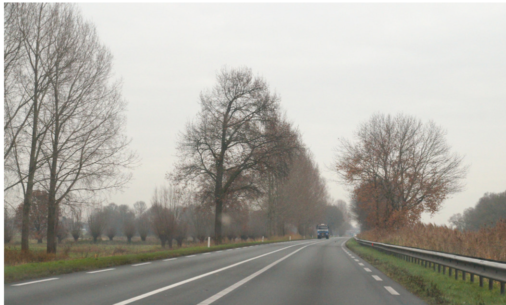
Waar mogelijk behouden bestaande waardevolle beplantingen langs de N279
