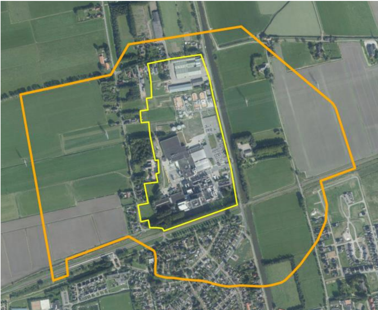
Figuur 9: Geluidszone industrieterrein
