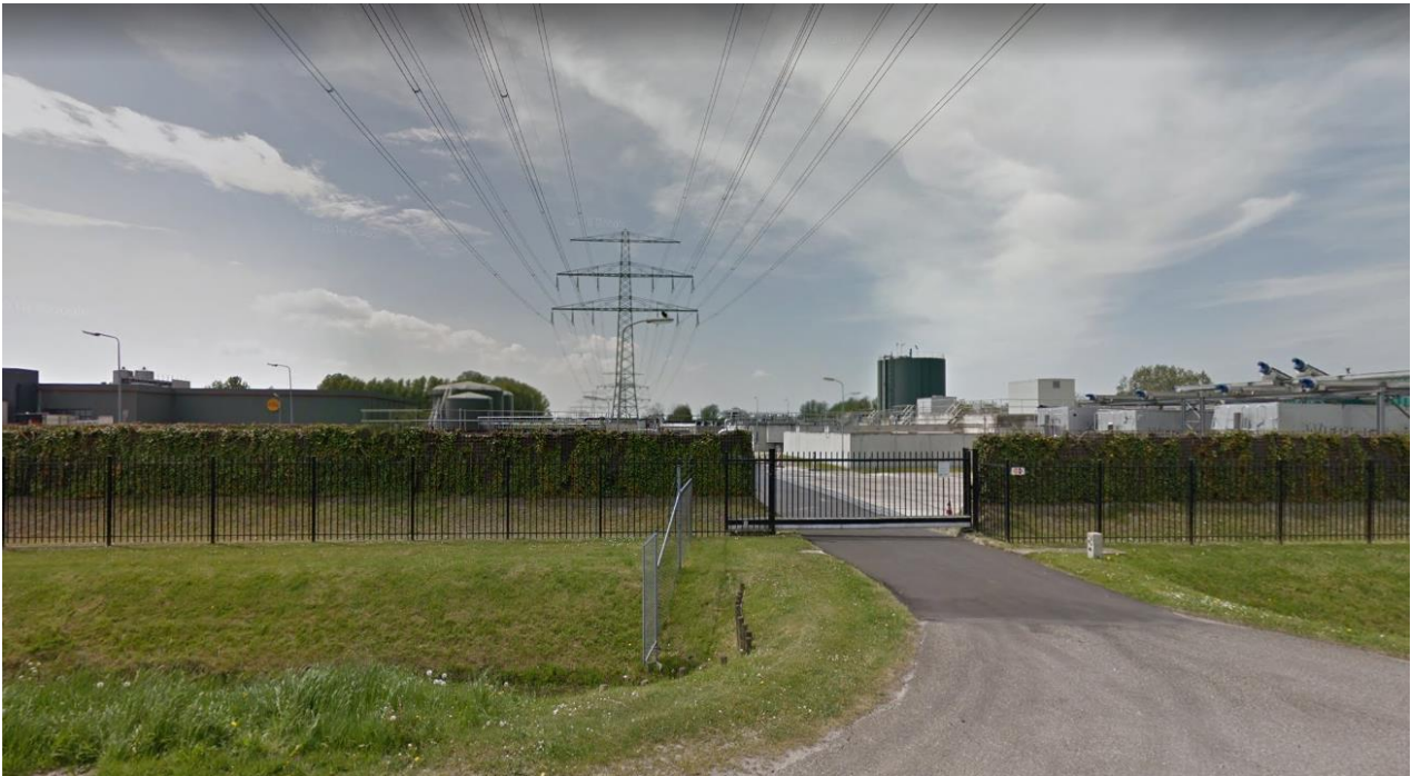
Figuur 19: 220 kV hoogspanningsverbinding over terrein FrieslandCampina Bedum
