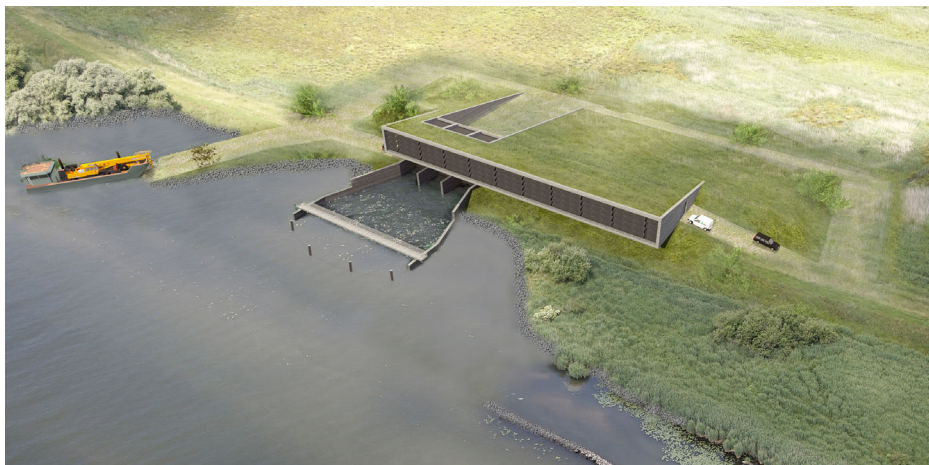
Figuur 2.8 Overzicht van het innamepompstation in de dijk van de Fortunapolder langs de Bergsche Maas. Links is de veerstoep te zien.
