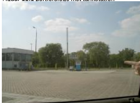
Figuur 11.1 portiersloge met tankstation
