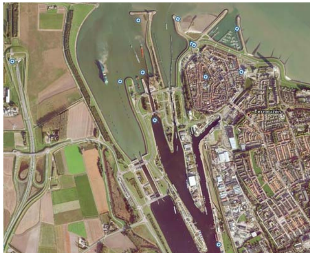
Figuur 1.1: Overzicht sluizencomplex Terneuzen
