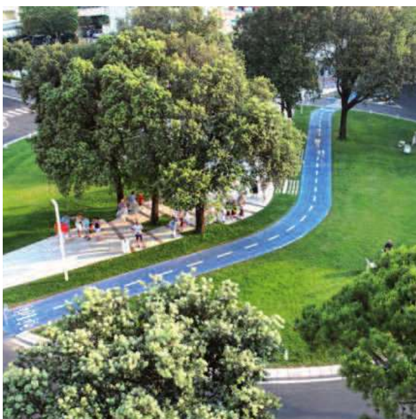
Centrale rijbaan loopt in afwijkende kleur over het parkeerweiland.
