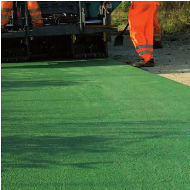
Gekleurd asfalt, verschillende kleurtonen gebaseerd op het omringende landschap.
