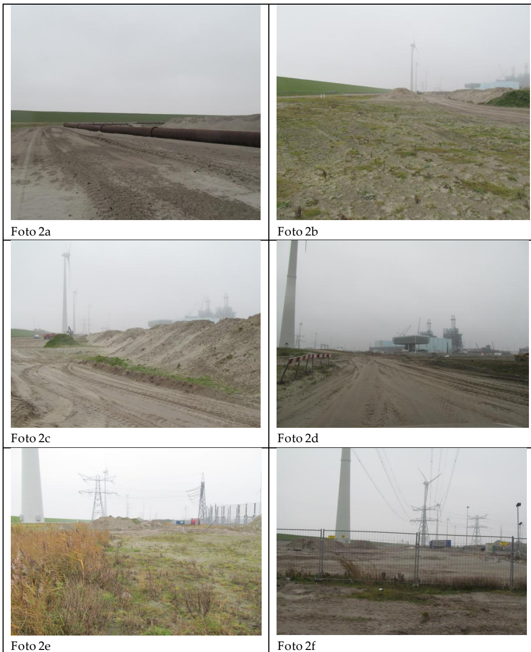
Foto 2 Kabeltracé oostlob Eemshaven.
