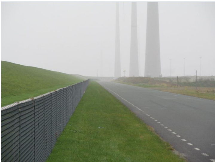
Foto 1 Kabeltracé westlob Eemshaven.
