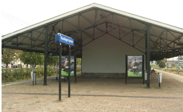
Figuur 4.10 Station Vlaardingen Centrum, karakteristiek stationsgebouw met overkapping.
