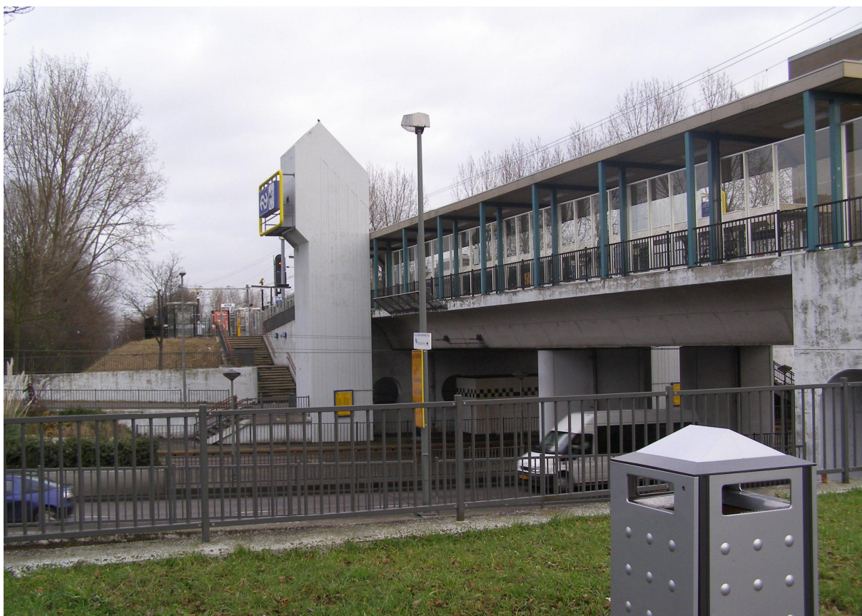
Figuur 4.3 Station Schiedam Nieuwland, gedeeltelijk op een viaduct over de Nieuwe Damlaan.
