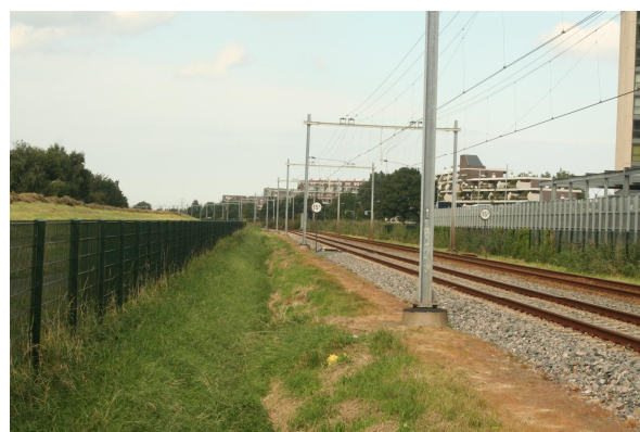
Figuur 4.23 Locatie station Maassluis Steendijkpolder, vanaf de zuidzijde van het spoor gezien.
