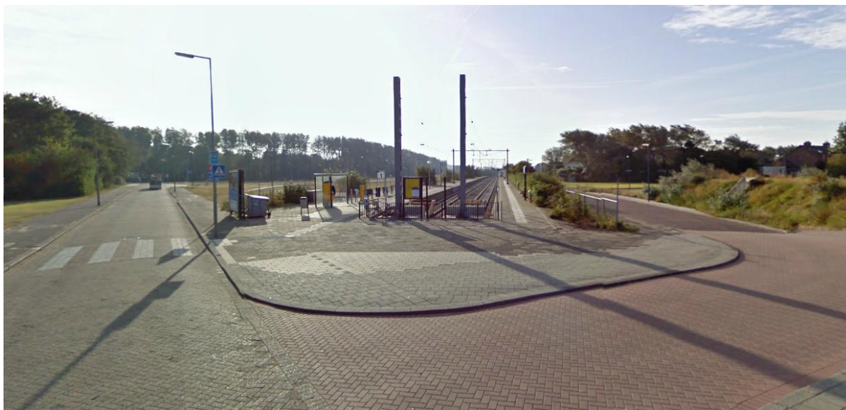
Figuur 4.27 Station Hoek van Holland Strand; links de Strandweg [bron: Google Street View].
