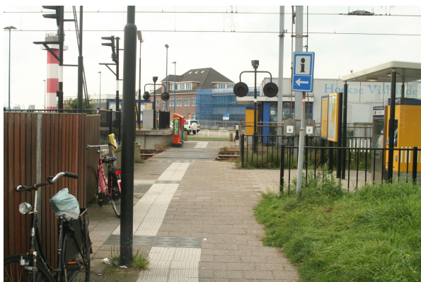
Figuur 4.25 Station Hoek van Holland Haven, links liggen de perrons.
