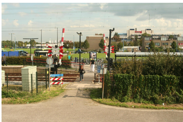
Figuur 4.19 Station Maassluis West, de spoorwegovergang met toegang tot de perrons, gezien vanaf de zuidzijde.
