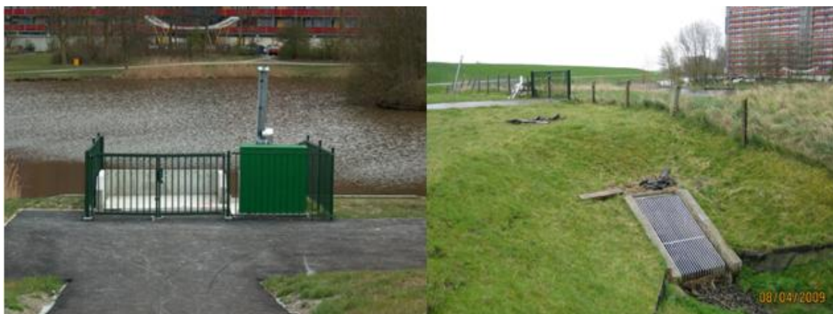
Figuur 4.2 Te verplaatsen uitstroomvoorziening (rechts) van gemaal Ladysmith(links)
