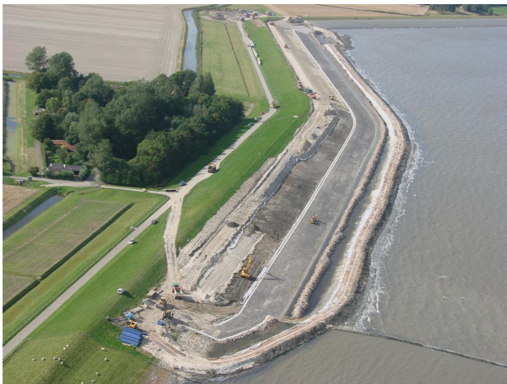
Figuur xx werkstrook buitendijks (dijkverbetering Nieuwstad, 2009)
