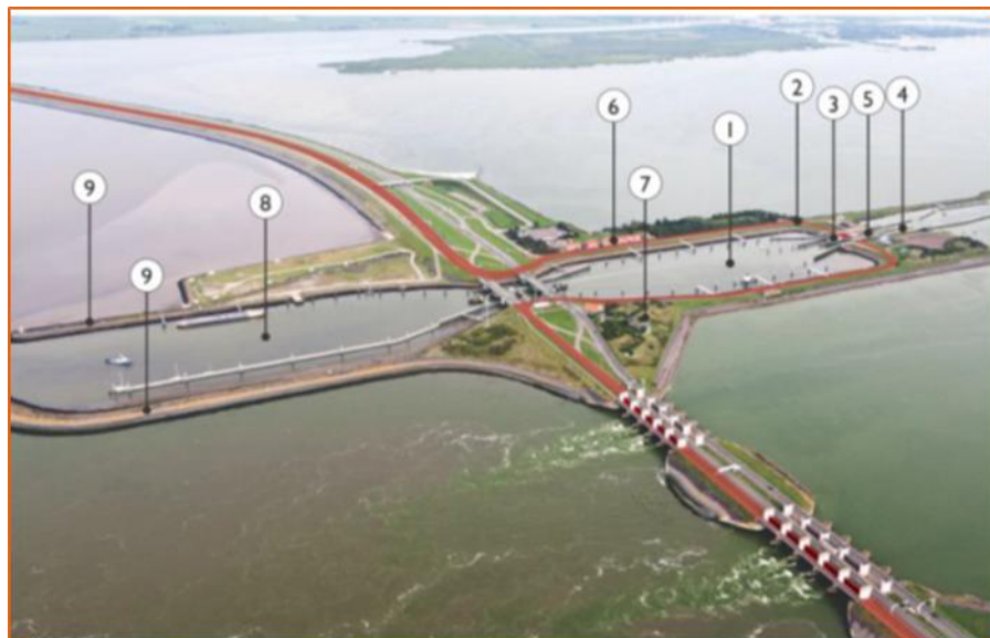
Afbeelding 5. Huidige situatie schutcomplex Kornwerderzand (bron plan/ project-MER Afsluitdijk)
