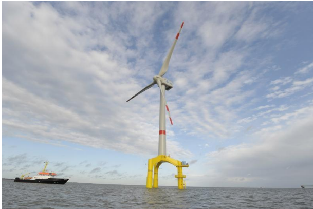
Figuur 1.5 Voorbeeld van een tripile fundatie 2
