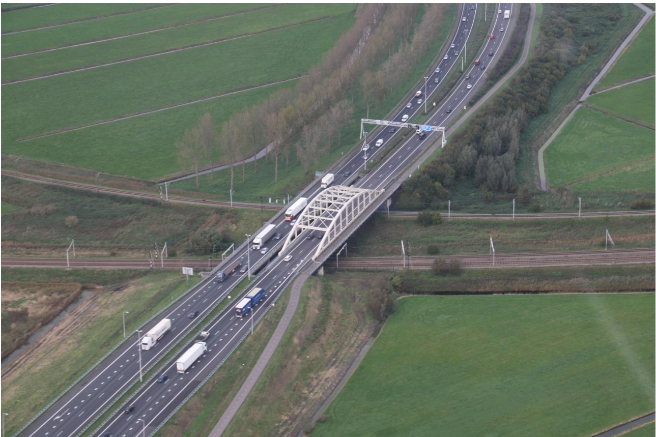
Figuur 8: Bestaande kunstwerken over de spoorlijnen, gezien vanuit het zuiden. De boogbrug ligt in de rijbaan richting Utrecht. Bij de voorgestelde optie 3 (verschuiven in oostelijke richting) wordt naast de boogbrug (rechts) een nieuw kunstwerk gebouwd.
