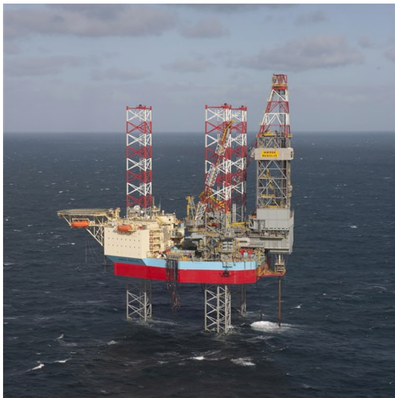
Figuur 4.3 Mobile boorinstallatie Maersk Resolve (bron: maerskdirilling.com).
