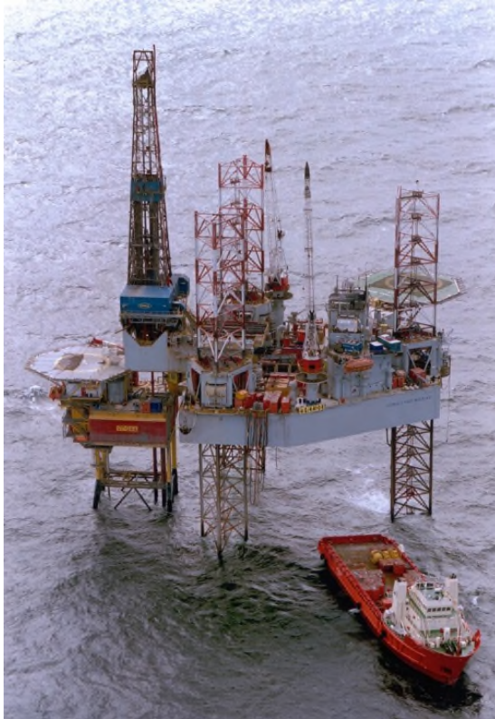
Figuur 4.4 Voorbeeld boorinstallatie (rechts, met naar links uitgeschoven boortoren) tijdens boring ter plaatse van een satellietplatform (links).
