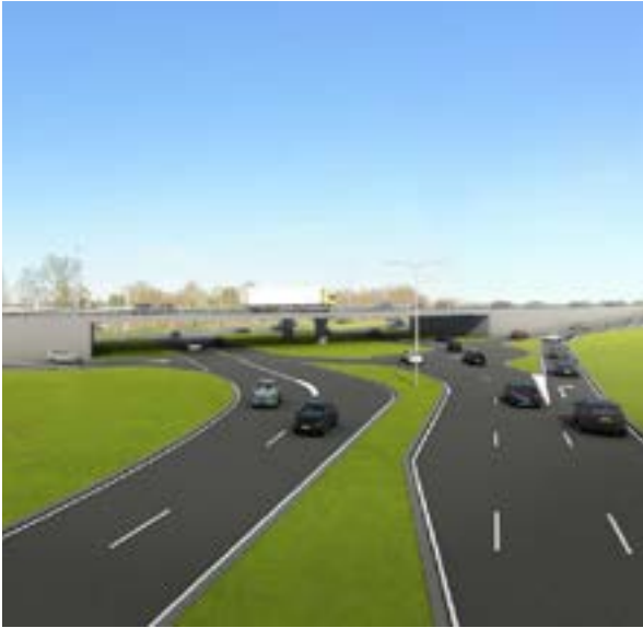
Kochplein verlengd viaduct (gezien vanaf Darwindreef)
