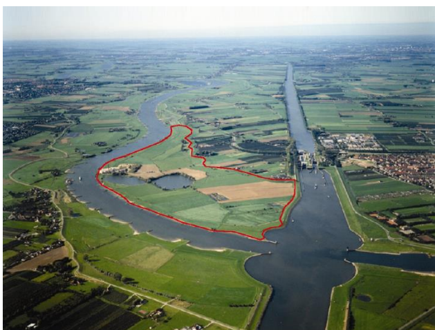
Figuur 1.2 Luchtfoto projectlocatie (Bosscherwaarden)
