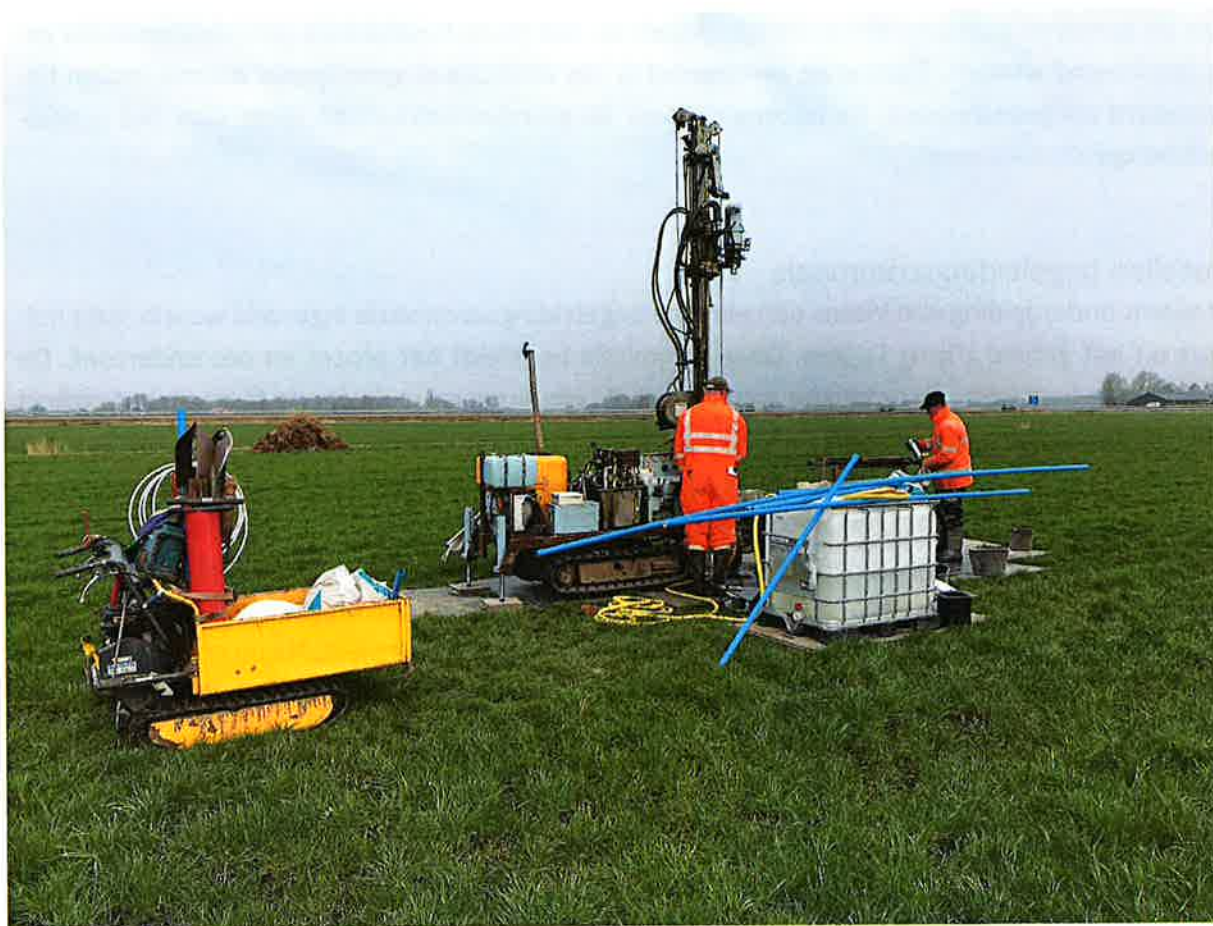
Foto 3: maken waarnemingsput in omgeving Luxwoude voor meting van grondwaterstanden
