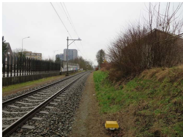
Locatie Kloosterkoolhof km 19.45 – 19.55 richting Heerlen (aan de rechterzijde van de spoorbaan wordt een keerwand geplaatst en de bovenbouw vergroot)
