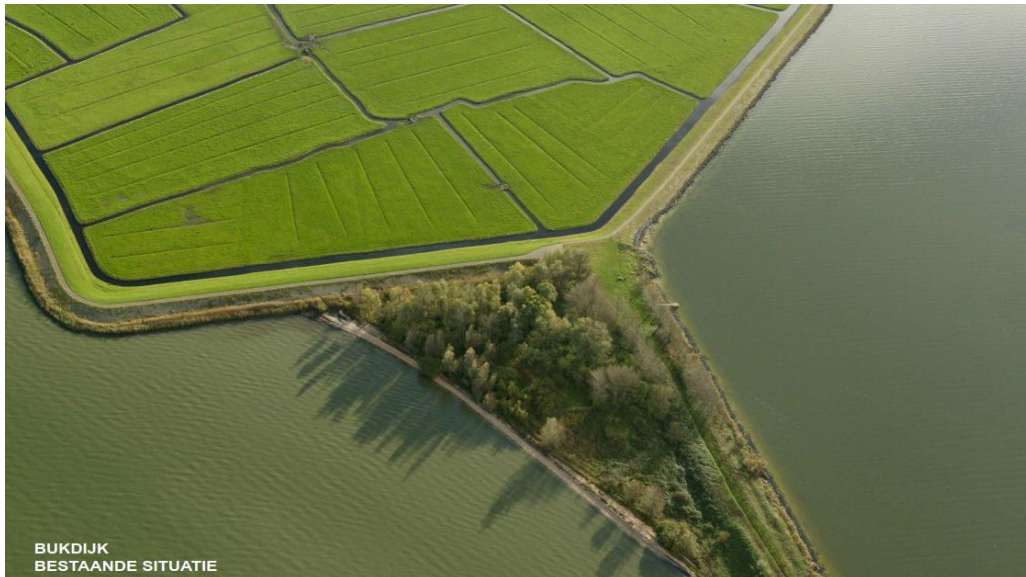
Figuur S.24 Bestaande situatie aansluiting Bukdijk op Marken
