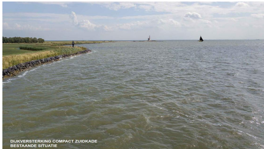
Figuur S.9 Bestaande situatie Zuidkade
