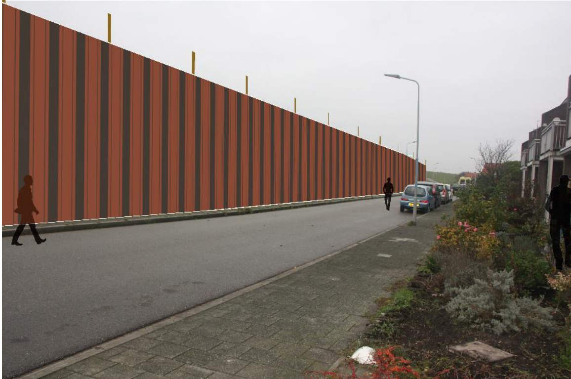
Afbeelding 4.10 Damwand 6,5 m hoogte in Dorpsrand Werfdijk (bron: RKK)
