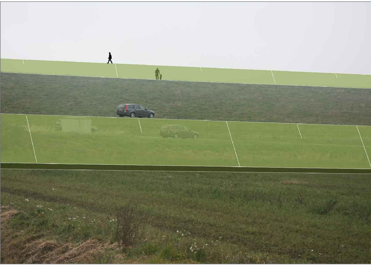
VERBEELDING GRONDAANVULLING BUITENZIJD MET STEUNBERM BINNENZIJD
