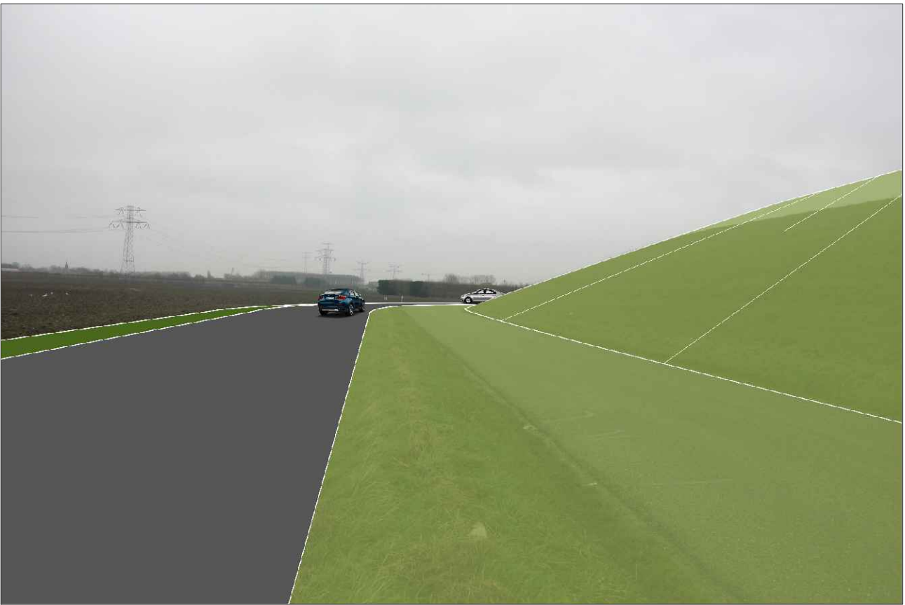
VERBEELDING GRONDAANVULLING BINNENZIJD MET STEUNBERM
