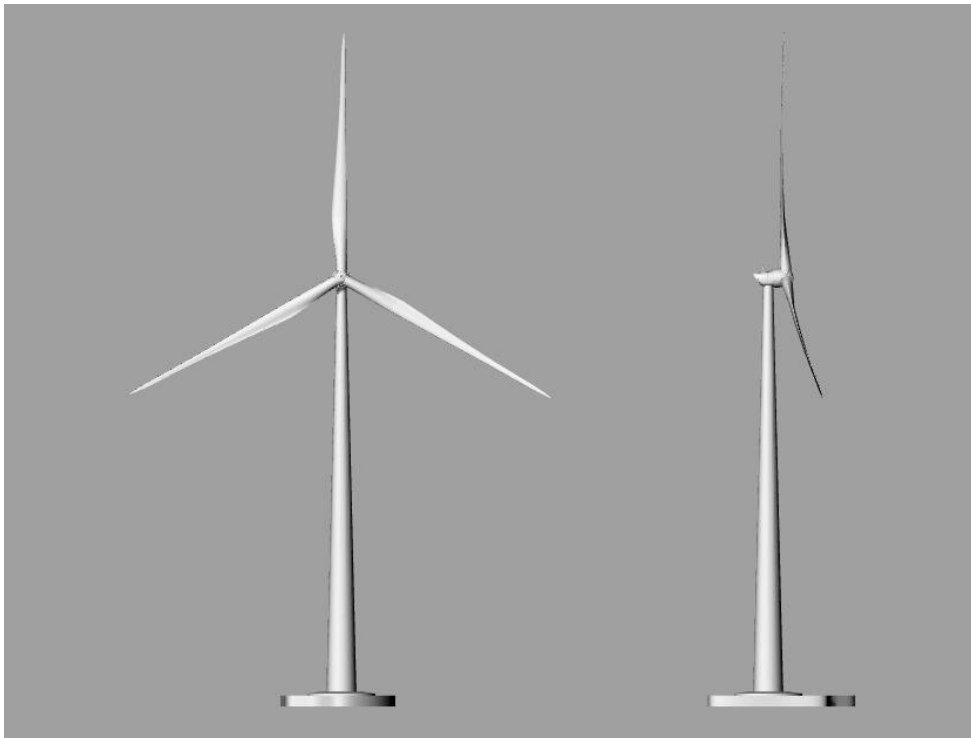
Figuur 5 De Lagerwey, L147 windturbine met een opgewekt vermogen van 4.3 MW, een ashoogte van 126 m en een rotordiameter van 147 m.
