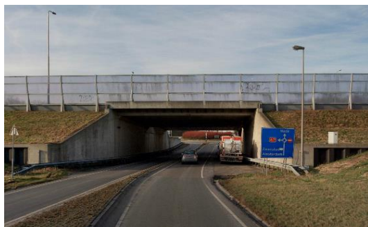
Figuur 10: bestaande onderdoorgang Laan der Continenten
