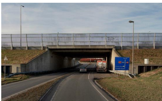
Figuur 27: bestaande onderdoorgang Laan der Continenten
