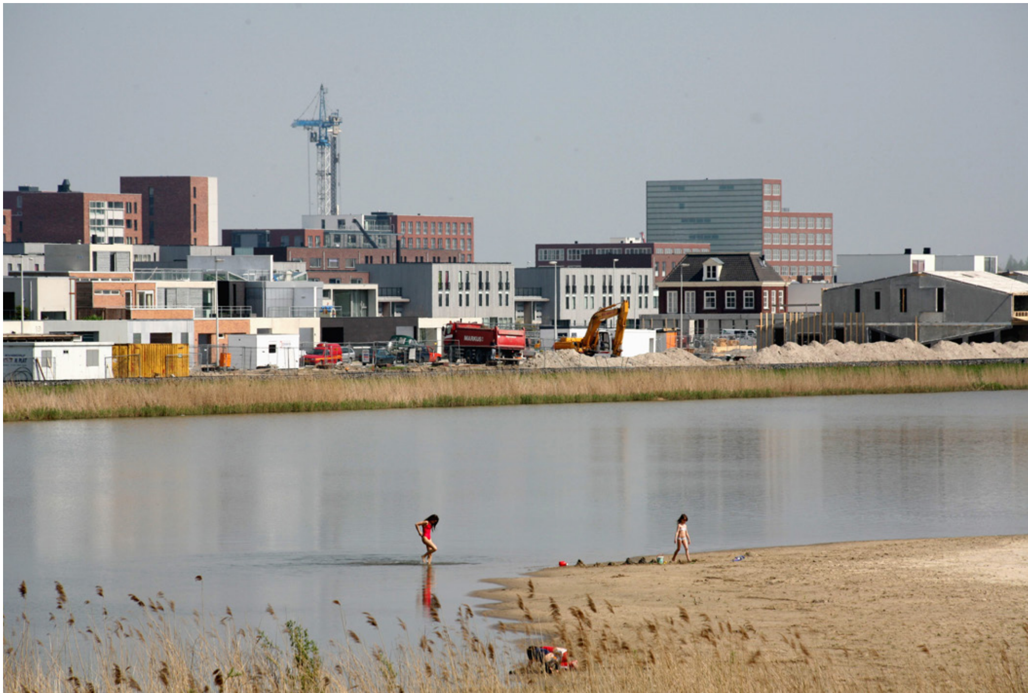
Afb. 6.1 Haveneiland in aanbouw
