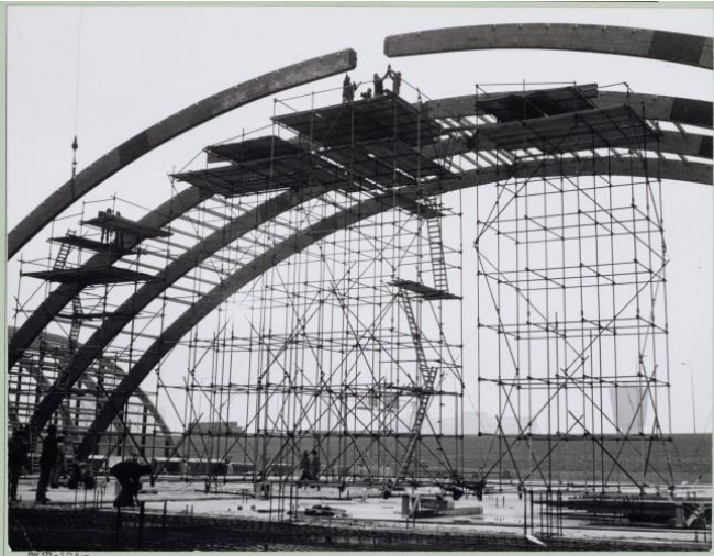
Sporthal in aanbouw 14-09-1974 Foto: Stadsarchief Amsterdam
