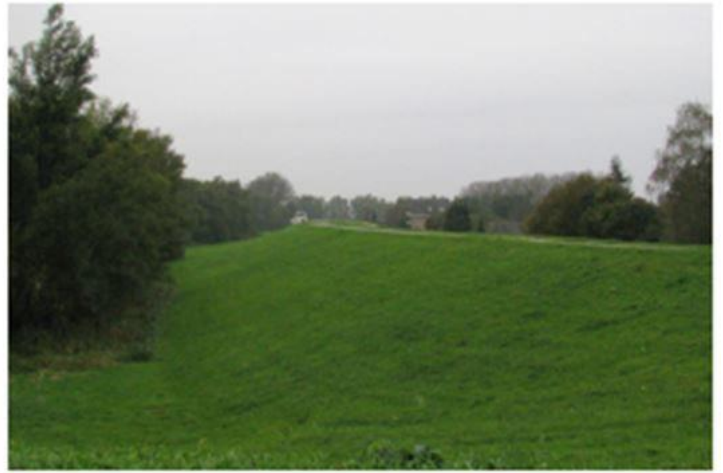
Kenmerkend profiel uit de jaren '80 met 1:3 taluds
