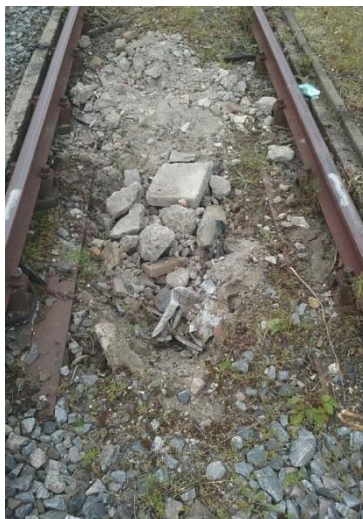
Foto 4.2 Voormalige inspectiekuil (betonnen bak) met puin
