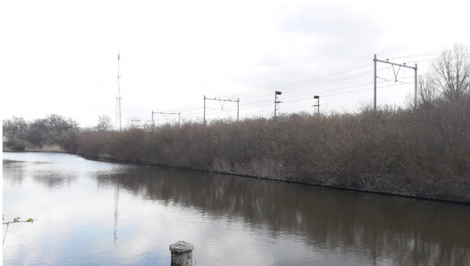
Figuur 5.2 Mogelijke route werkterrein ter hoogte van de Contactweg. De struwelen en bosschages op het talud zijn geschikt als broedbiotoop voor algemene broedvogels.
