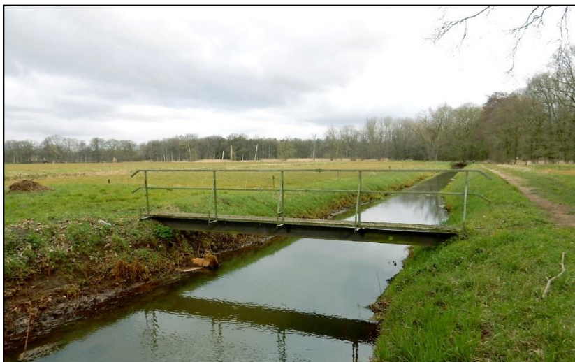
Figuur 53: Te verwijderen brug
