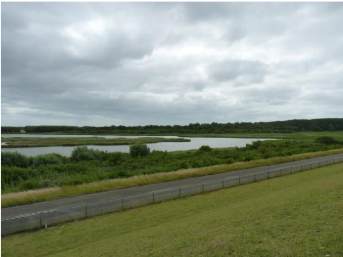
Foto 1 - de binnendijkse kwelzone in de Marnewaard (foto's A&W).
